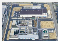
廃液処理工場
